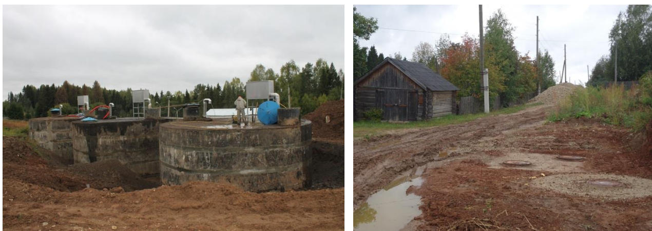
Строительство сетей водоснабжения в с. Среднеивкино Верхошижемского района (начато в 2019 г.)
